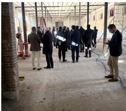
Travaux dans le HUB 696
