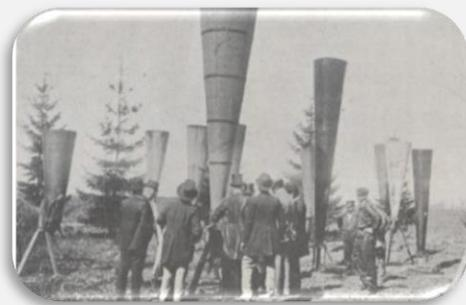
Une batterie de "canons à grêle" pour vérification de l'efficacité du concept
