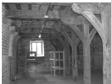
Intérieur de la poudrière de Tréfaven
